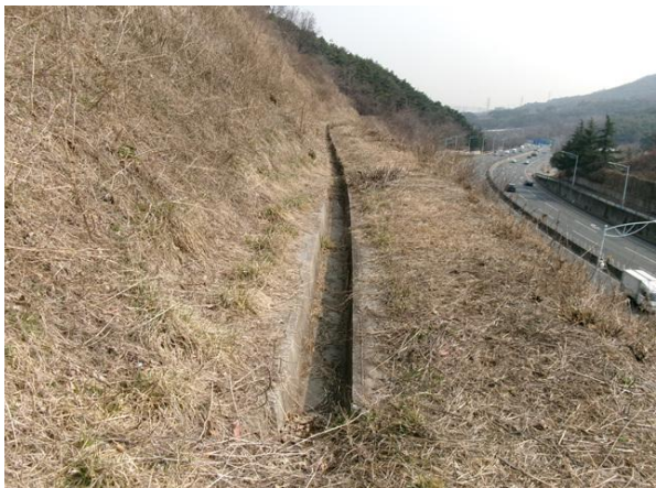
1소단 배수로 전경
