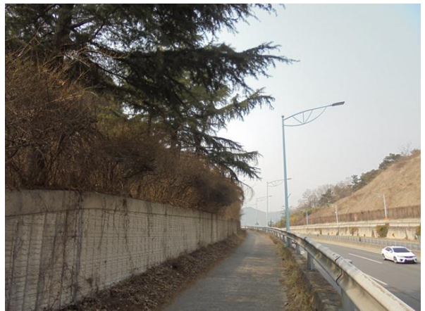
낙석방지울타리 및 하부 전경
