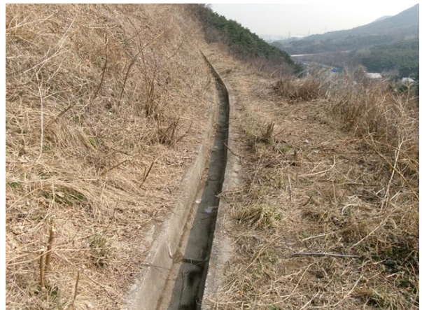
2소단 배수로 전경
