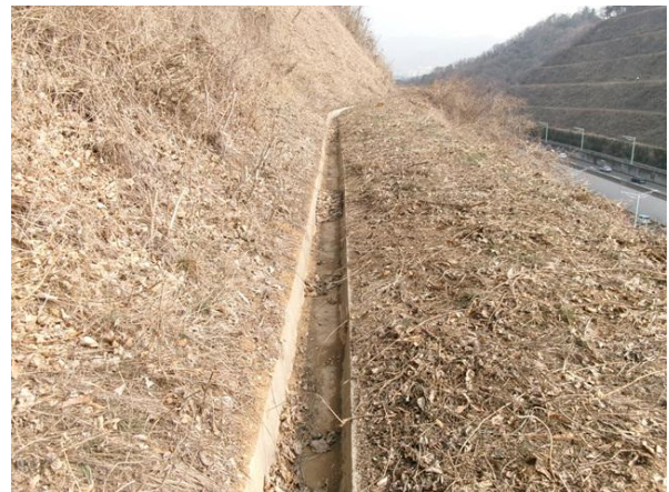
2소단 배수로 전경
